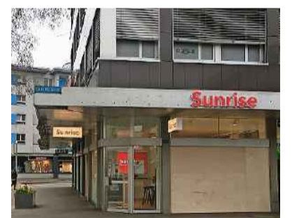
Das zerstörte Schaufenster wurde provisorisch durch Bretter ersetzt. (DEG)
